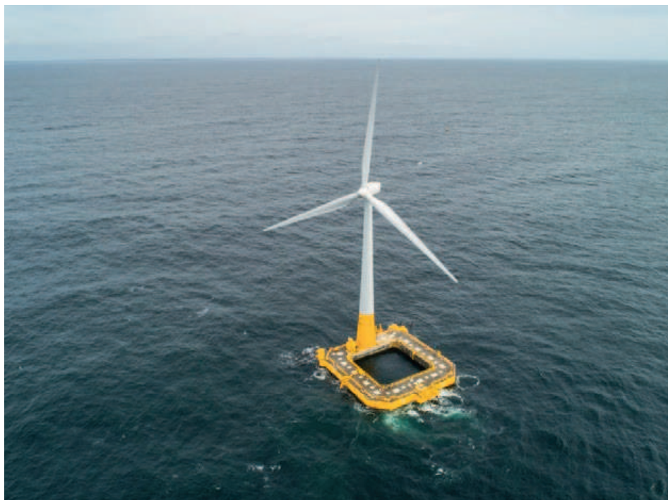
Floatgen , première éolienne flottante installée au large des côtes françaises. © Ideol / ECN / V. Joncheray.
