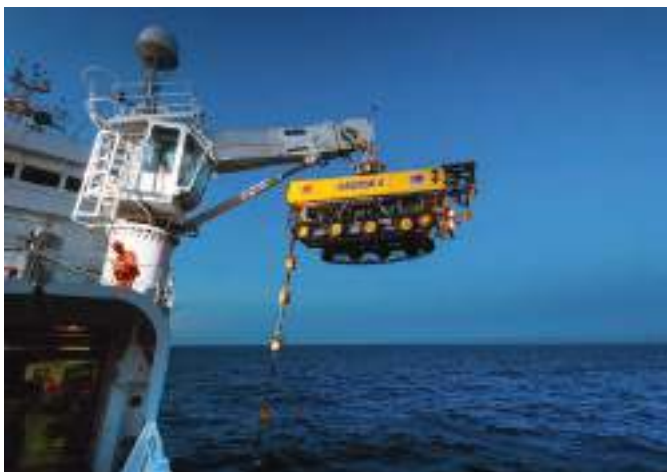
Pose d'un câble sous-marin par un navire d' Orange Marine . © Geoff Brown.
